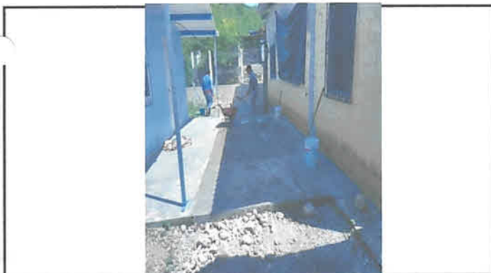
Foto 3: Ampliación de techo del corredor
